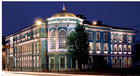
Архитектурно-художественная подсветка фасадов более 60-ти зданий, Москва
